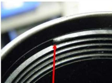
Korrekter, unbeschädigter Gewindeansatz
